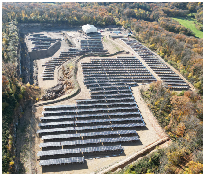
Centrale vue du ciel © Égrega
